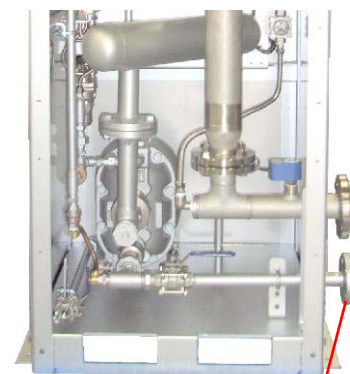
ドレン出口配管
