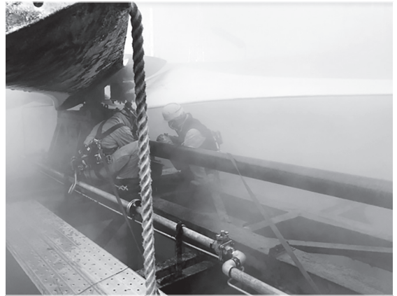
写真2 冷却塔でのレーザー発射器の取り付け
