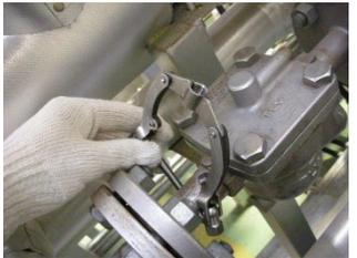
2. 固定クランプのネジ部分に、センサー先端をねじ込み、設置高さを調整します。
