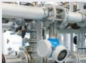
※蒸気など高温ラインでご使用の場合、熱による影響を最小限とするため、上下逆の取り付けを推奨しています。
