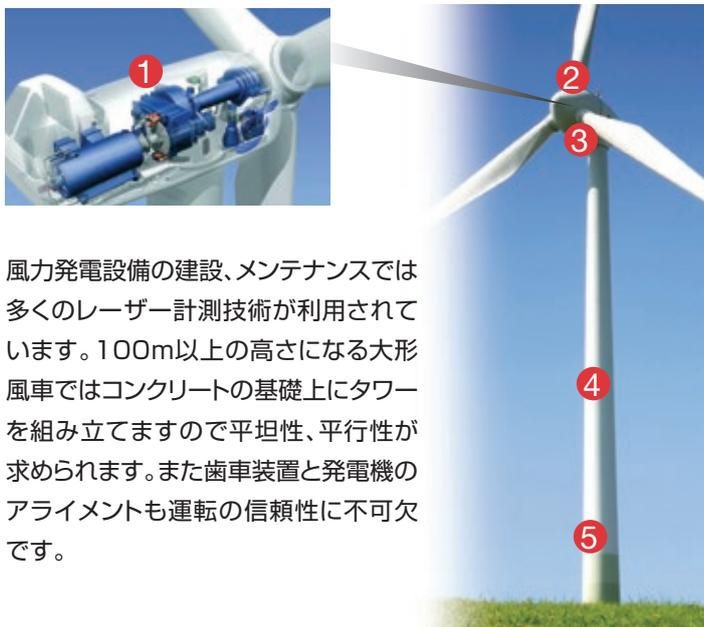
風力発電設備の建設、メンテナンスでは多くのレーザー計測技術が利用されています。100m以上の高さになる大形風車ではコンクリートの基礎上にタワーを組み立てますので平坦性、平行性が求められます。また歯車装置と発電機のアライメントも運転の信頼性に不可欠です。
