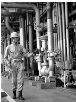
写真4 エア・ガスリーク診断サービスの実施風景
