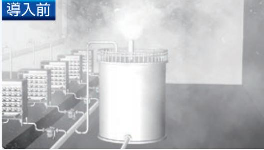
大気開放のドレン回収タンクからフラッシュ蒸気が発生しても、タンクに圧力を掛けられないため、従来の熱交換器では対応が不可能でした。
